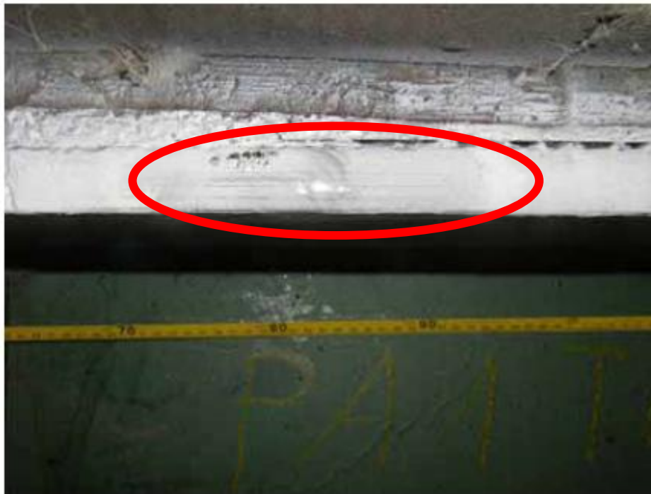
Abb.-Nr.: 15 Prüfabschnitt von 70 bis 90 cm Gurtlamellen SB
